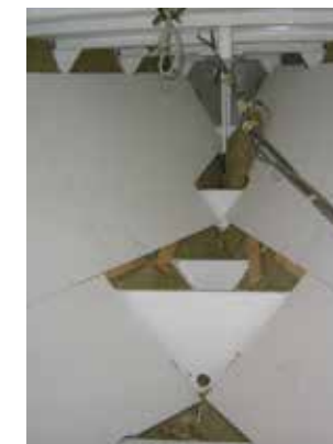
Het vooronder wordt aangepakt. Met een nieuwe indeling en nieuwe isolatie.
